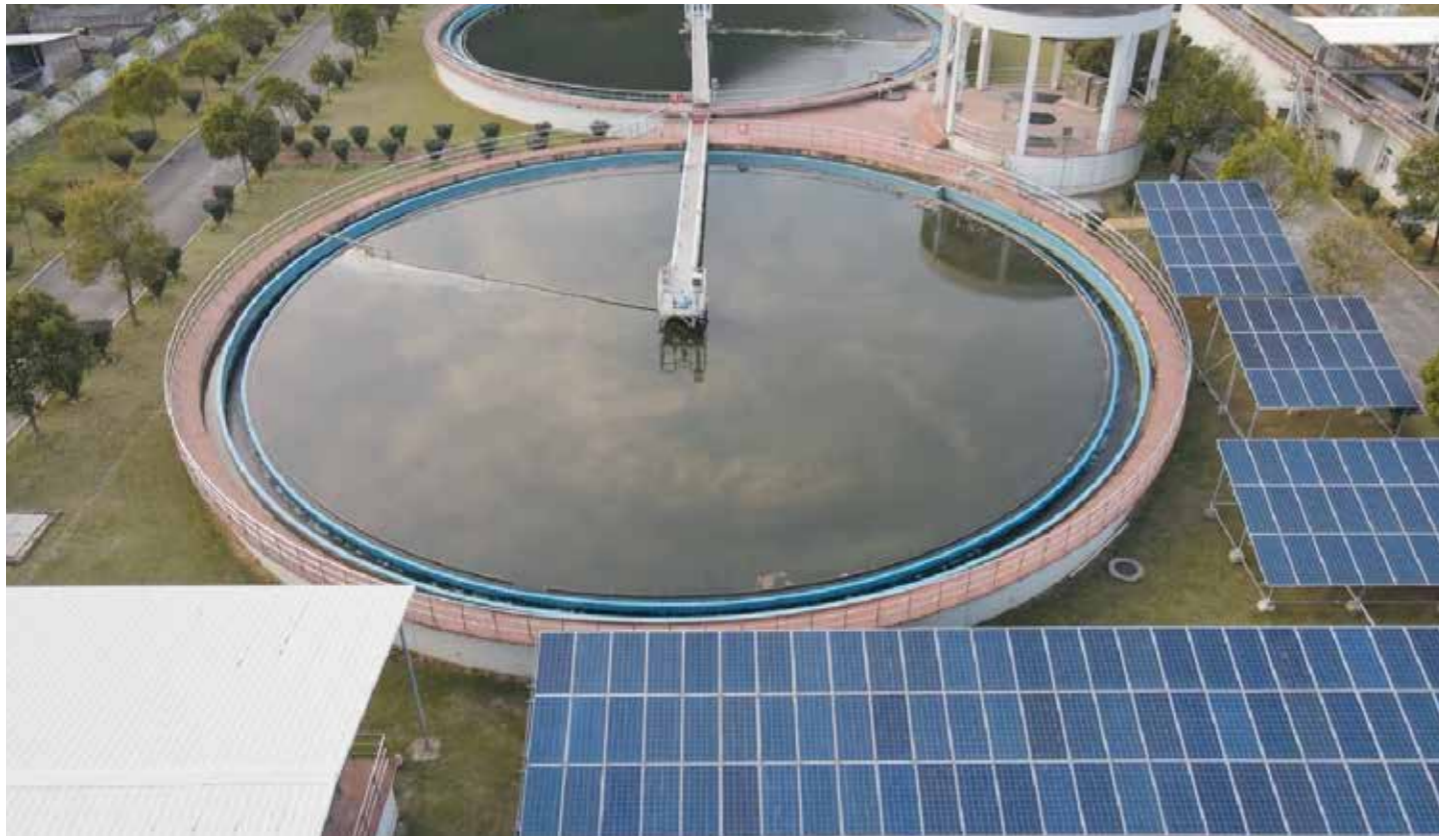
Umweltfreundliche Synergie: Effiziente Reinigung und nachhaltige Energiegewinnung durch Kläranlage mit Photovoltaik
