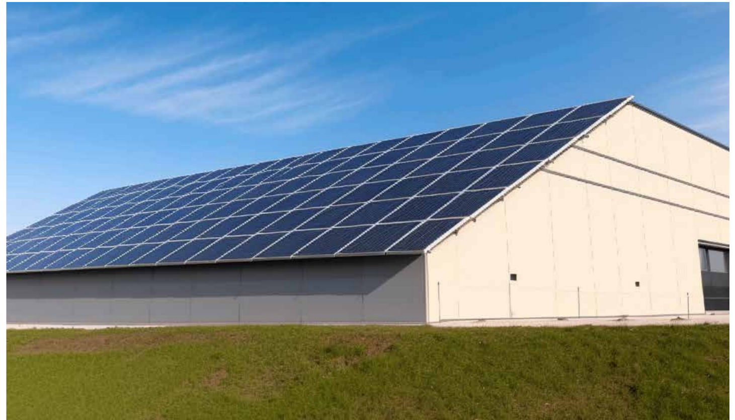
Nachhaltige Wasserversorgung: Wasseraufbereitung und Photovoltaik für eine saubere Zukunft
