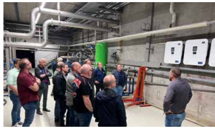
Kläranlage Bad Schussenried: Autarke Energieversorgung
