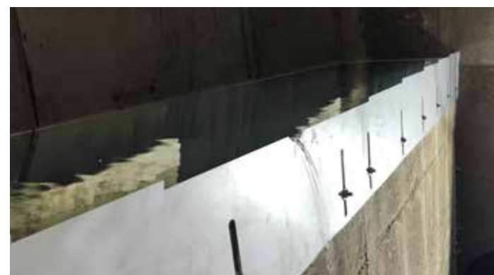
Überlaufschwelle mit SensoMatic-EMA Messprofil
