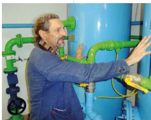
Links: Steinhilber vor der neuen Einstiegs- klappe des Hochbehälters Hornberg. Rechts: Steinhilber im Pumpwerk Egental. Von dort wird das Trinkwasser derzeit direkt in den Hochbehälter gepumpt.
