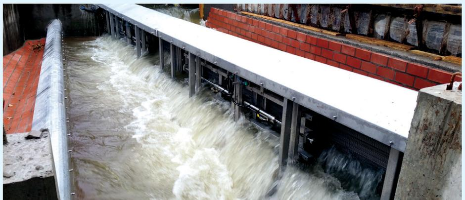
Bild 1 Horizontalsiebmaschinen mit IntelliScreen-System /5/
