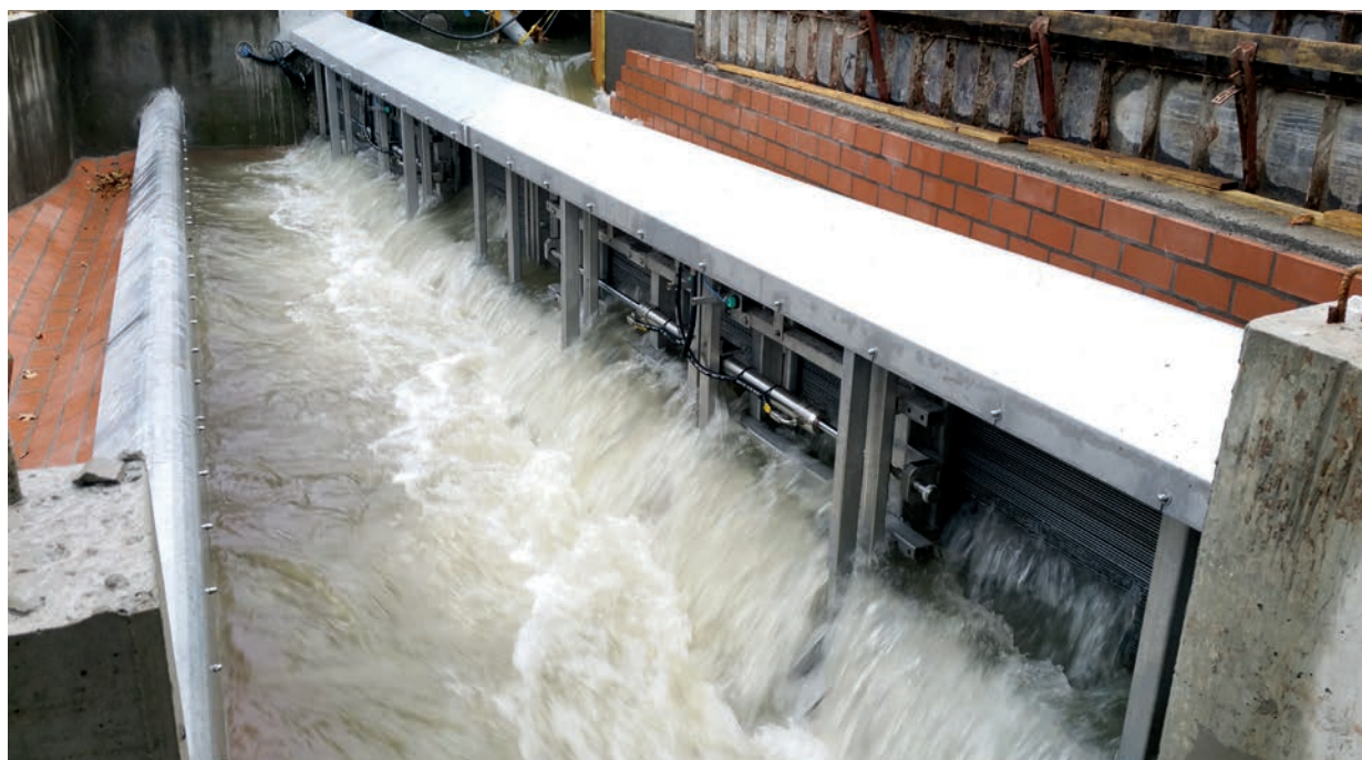
Bild 1: Horizontalsieb mit IntelliScreen-System [5]
