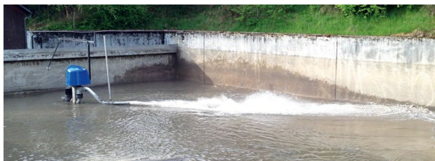
Bild 1: Schwenkstrahlreiniger in einem Regenbecken (Quelle: [13])
