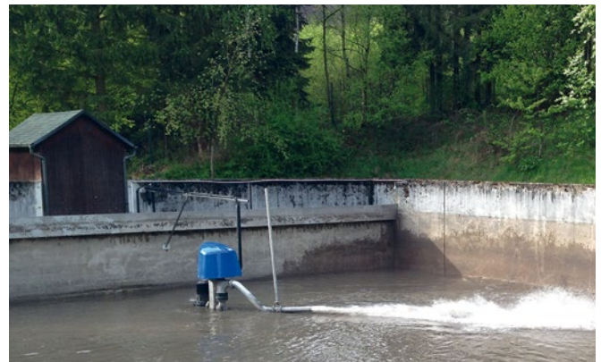
Bild 2: Smarter Schwenkstrahlreiniger in einem Regenbecken [13]
