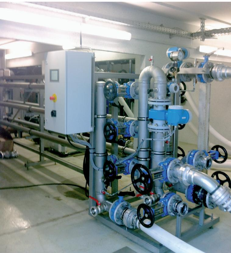
*Abb. 2: Abwasser-Wärmerückgewinnungsanlage*
